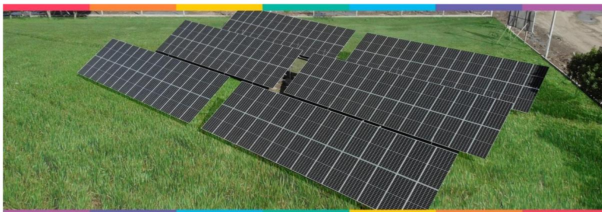
El Parque Solar Comunitario de Oncativo se encuentra funcionando a pleno. El mismo cuenta con 168 paneles de 455 Wp cada uno con una potencia de generación total de **76,44 kWp** y una potencia de acople de **60 kW** y ha inyectado a la red, durante el presente ejercicio, **106.7603 kWh** de energía de origen renovable.
